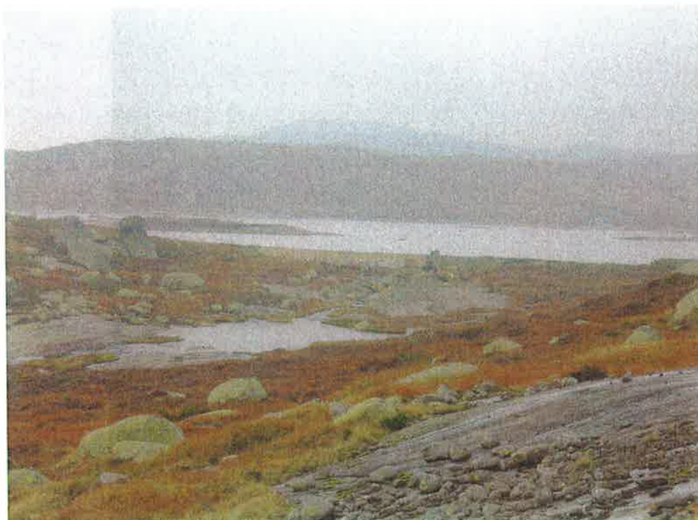
Bilde 5: Oversikt over Bergetjørn. Østre dam med luke
