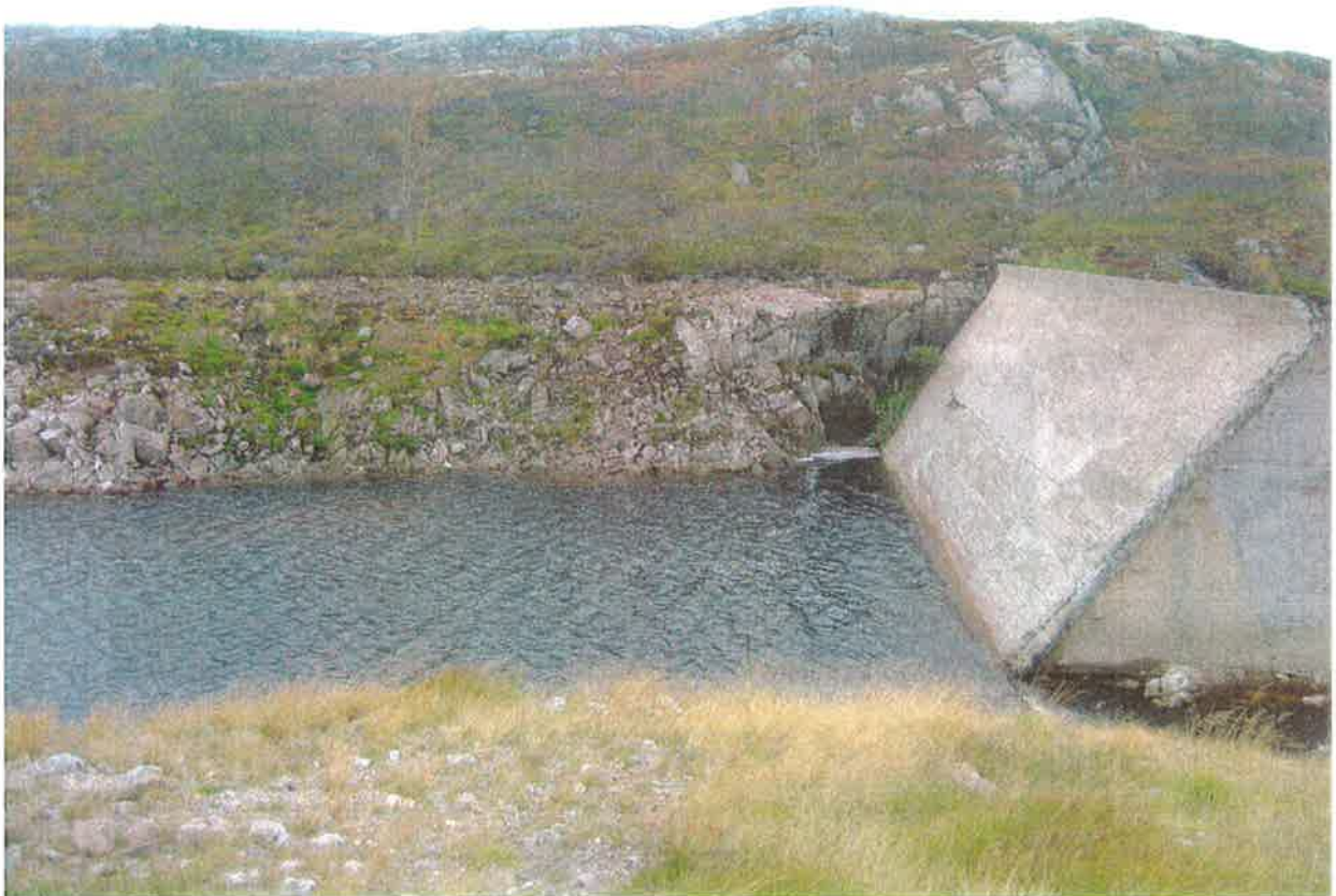
Bilde 1: Inntaket plasseres i forbindelse med dam.
