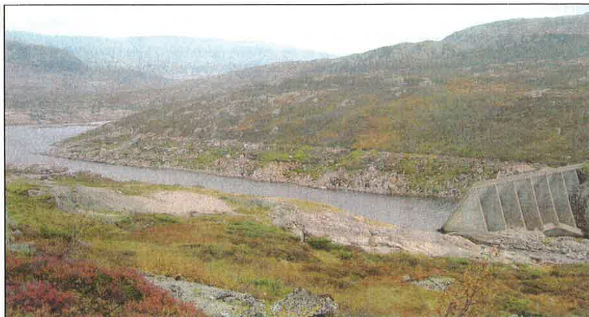
Bilde 6. Finndalsvatnet slik det fremstår i dag, ca 15 år etter nedtapping etter en lengre oppdemningsperiode. Til høyre i bildet ses restene etter den gamle demningen som delvis ble revet i 1994.
