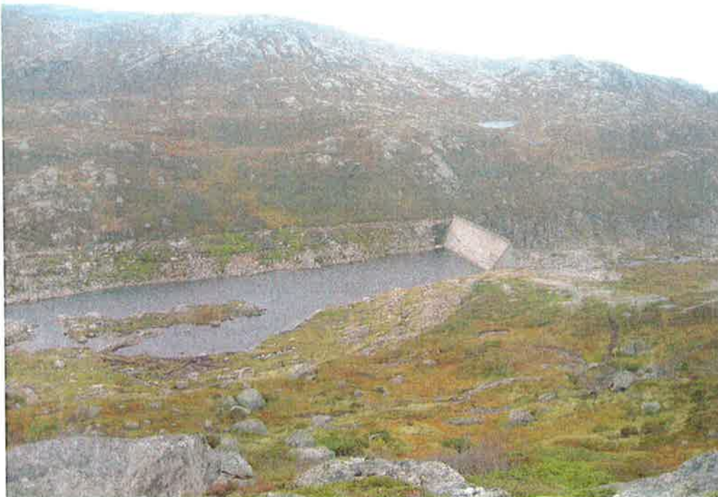
Bilde 2: Oversikt over Finndalsdammen.
